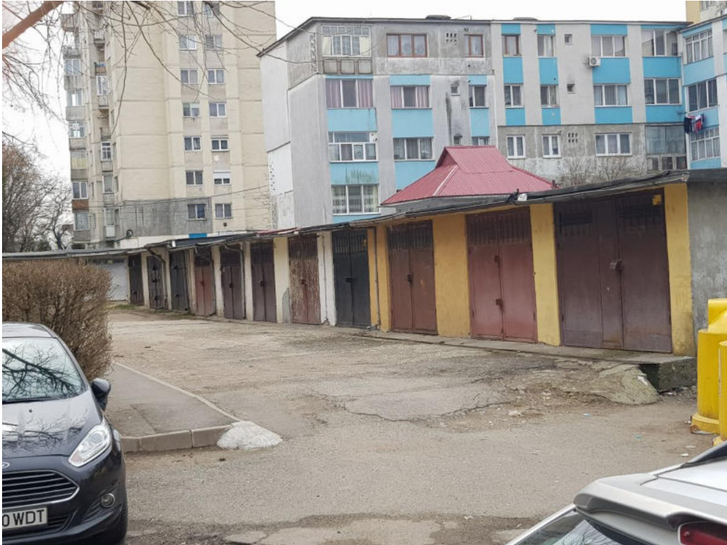
Figură 2-31 - Baterii de garaje Baia Mare – Cartierul Depozit
