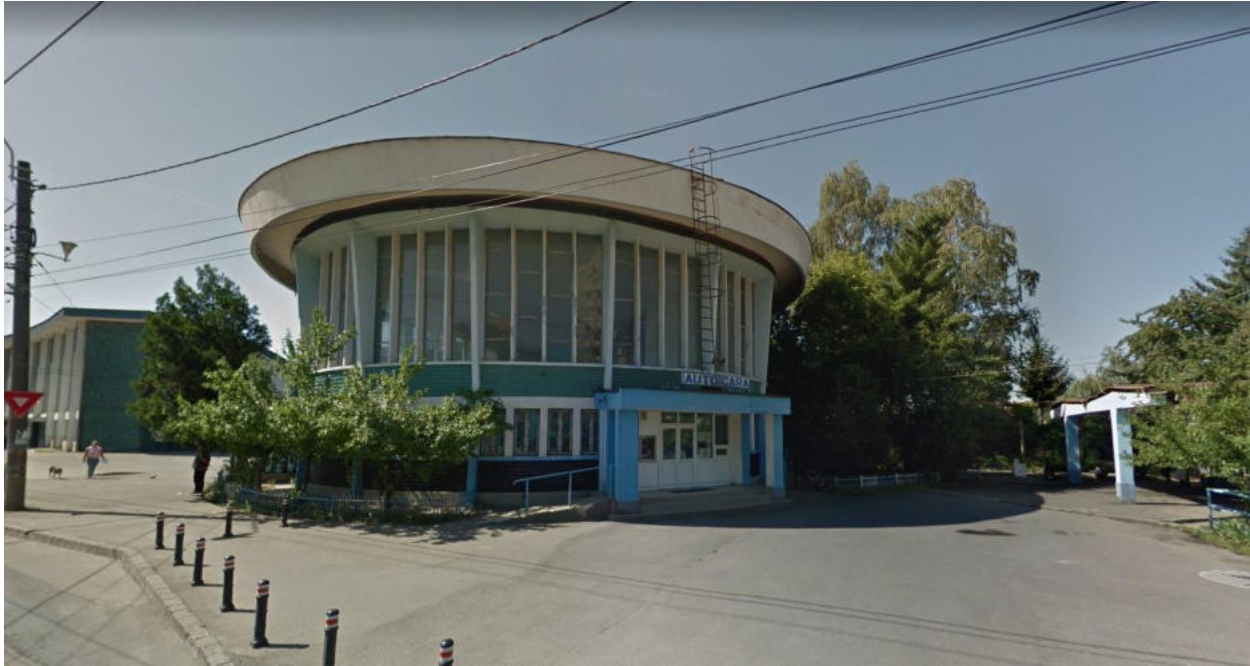
Figură 2-41 - Corp principal Autogara Baia Mare
