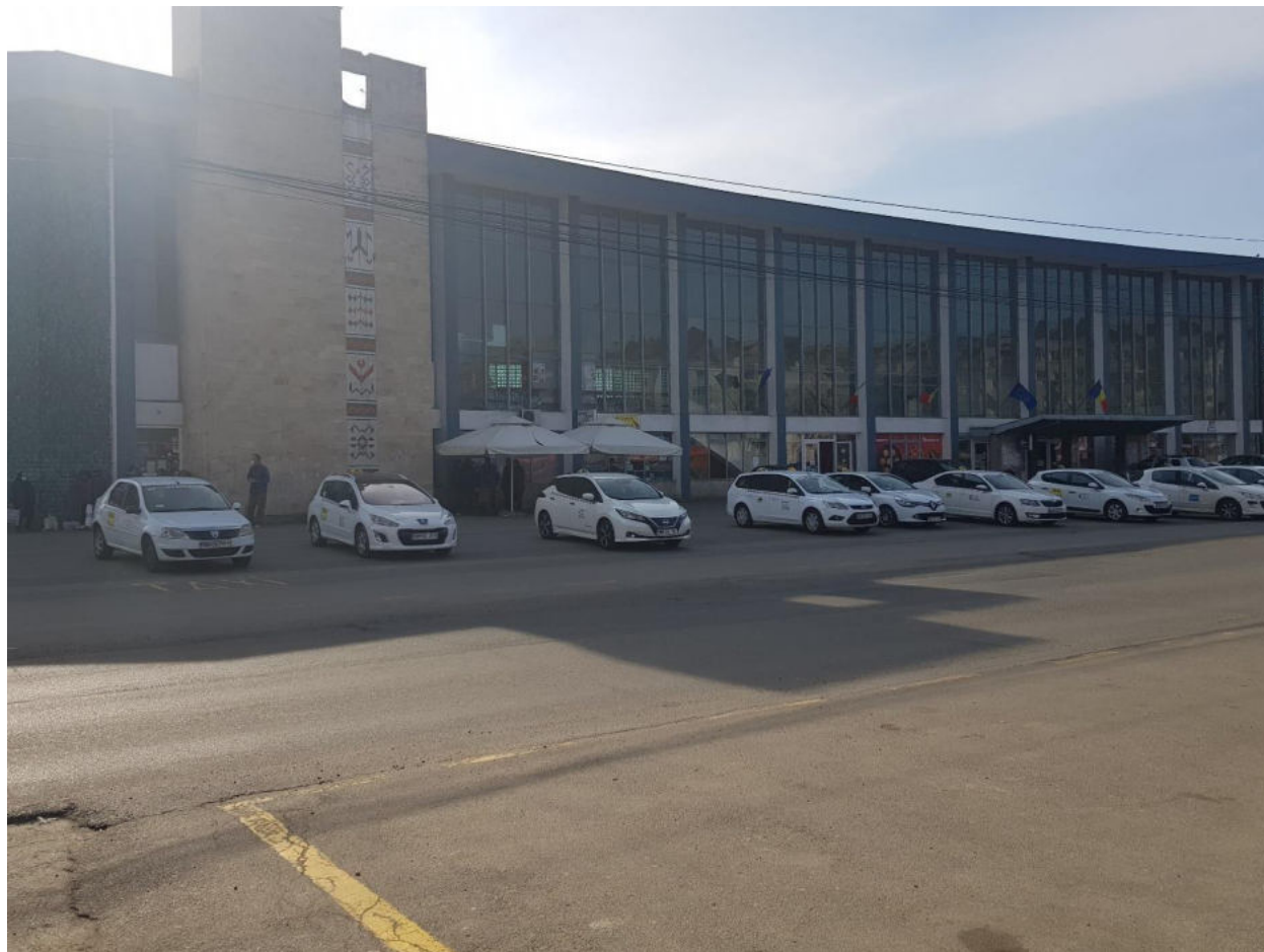
Figură 2-52 - Gara Baia Mare - Stație de Taxiuri
